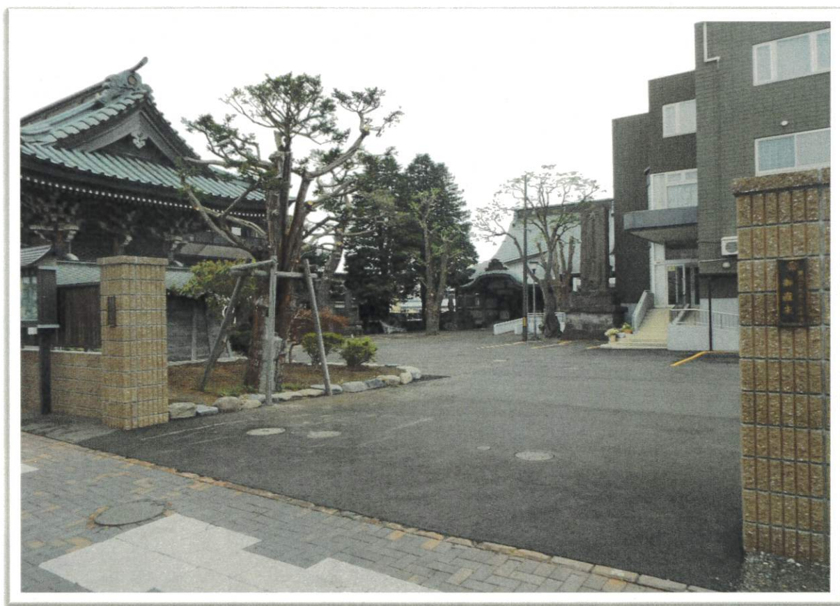
正面通用門側（旧道側）より境内の眺め
