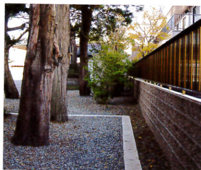
改修後のブロック塀
